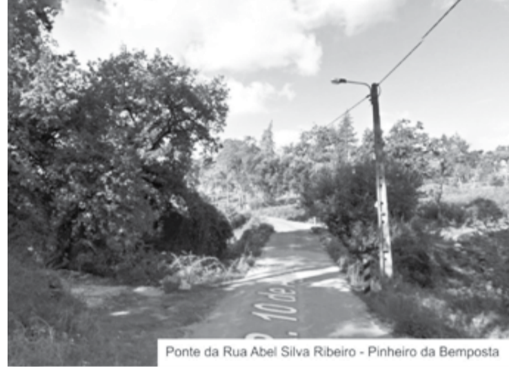
Ponte da Rua Abel Silva Ribeiro - Pinheiro da Bemposta
